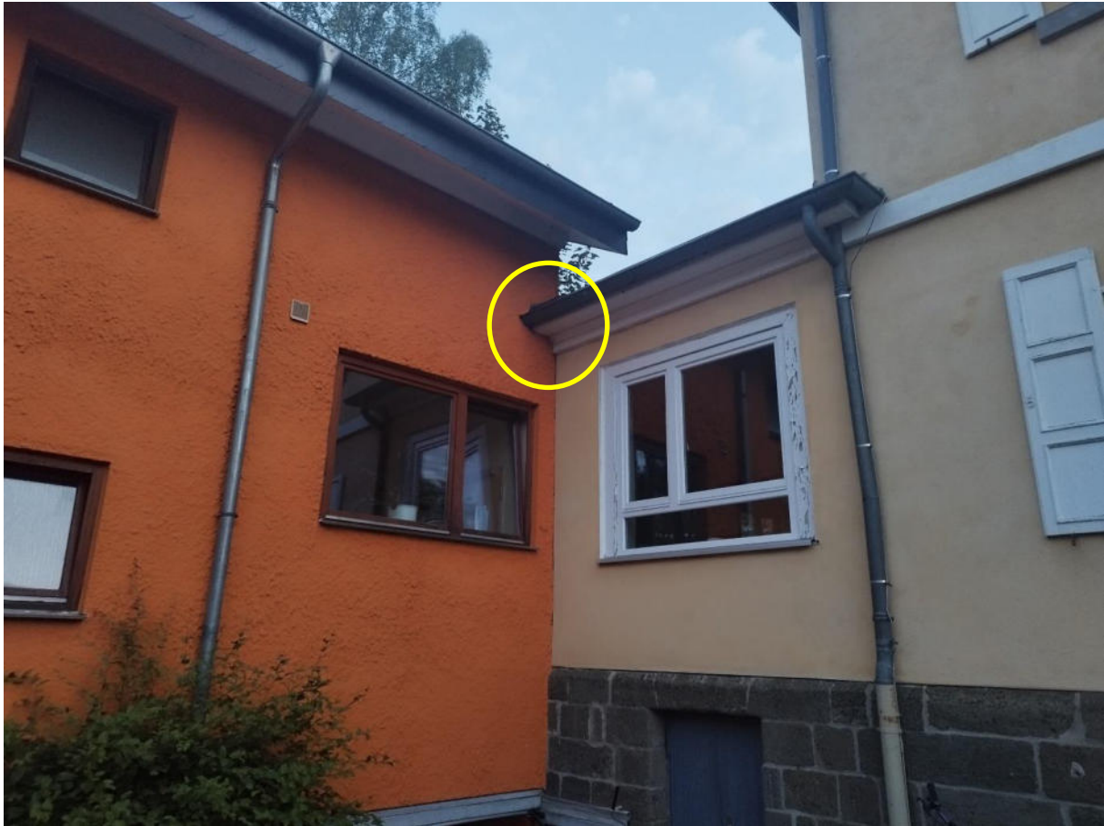
Abb. 4-1: Wochenstubenquartier zwischen Dachvorsprung, Regenrinne und Fassade von Gebäude Nr. 27. Im Bereich der gelben Markierung wurden Zwergfledermäuse beim Einflug in die dahinterliegenden Strukturen beobachtet.
